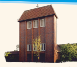
Martin-Luther-Kirche Mittelweg 5, Nordenham
